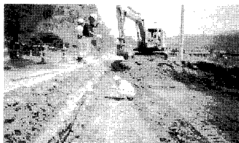
(a) 現場の掘削
