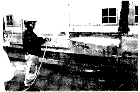
写真1 高圧洗浄実施状況
