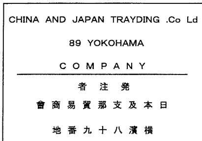
図2 第2三崎町通り架道橋の銘板
