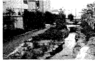
写真3 せせらぎ水路③区間
