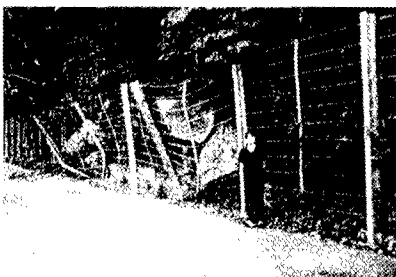
〈写真-1〉 崩落による落石 ①
