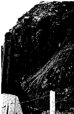
写真 1. 落石落下斜面
