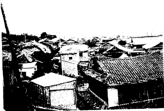
写真—3 写真—1, 2 から数 100m離れた海岸砂質低地では、木造家屋にかなりの被害が見られる。
