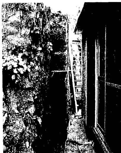
写真—4 正面スケールのあててある岩の面が断層面で約 20 cm ずれて、その延長が右の家屋の床下を通ったが、家屋はゆがんだだけで、倒壊はしなかった。庭の盆栽は棚から落ちなかったので加速度は大した事は無かったのかもしれない。
