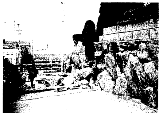
写真二 写真一の延長上の断層であるが、断層の通過した石垣、道路コンクリート舗装は壊れているが、隣接した石垣は全く無被害である。
