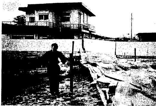
写真一 ビニール・シートのかけてある断層の通過した塀は壊れているが、その断層から30cm離れた二階家は、窓ガラスも割れていない。(1995年兵庫県南部地震、野島断層、M7.2)
