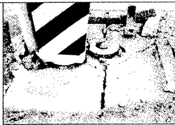
図-3 P2橋脚ピボットシューの逸脱
