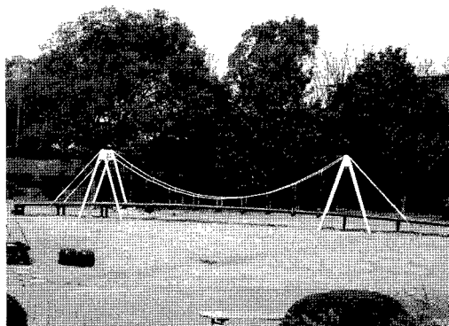
写真-1,2 (中央スパン 10.0 m, サグ比 0.2, 側径間比 0.0, 主塔高 3.0 m, 補剛桁長 18.0 m, 幅員 0.9 m)
