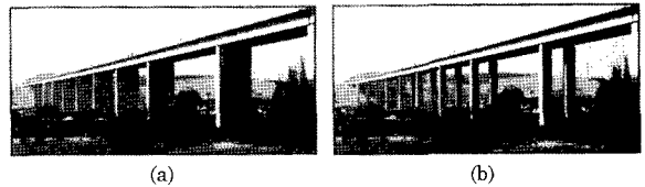
写真-3 透過性・量感（二本橋脚を用いた例）
