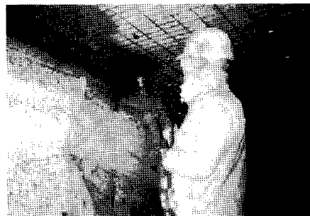
写真2 吹付け施工状況
