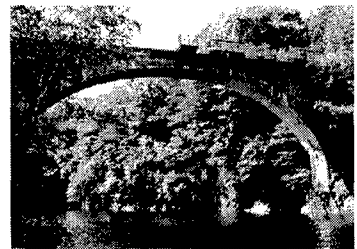
写真1 旧土幌線第三音更川橋梁
