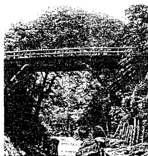
写真-2 木造方杖橋
