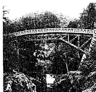
写真-3 木造トラス橋
