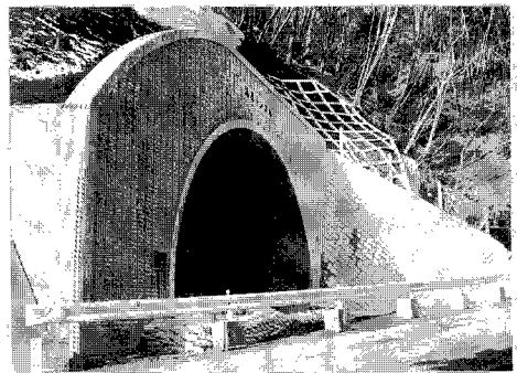
坑門完成全景（道路中心直交方向より）
