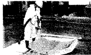
写真-1 樹脂吹付け状況
