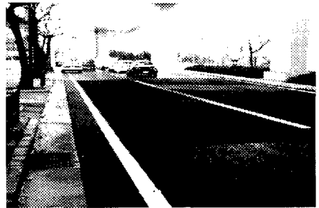
写真－１ 試験舗装状況
