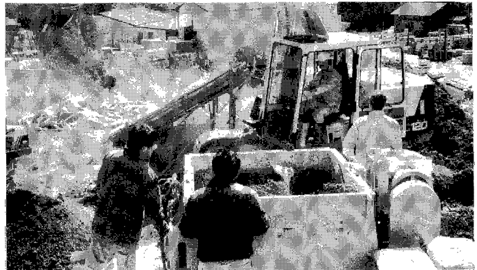
写真1 発生土等材料の練混ぜ
