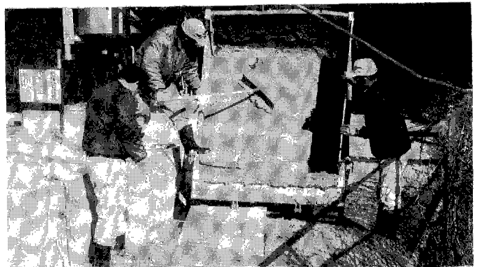
写真2 現場打設の状況
