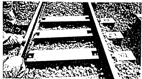
②締結装置部を利用した移動防止
