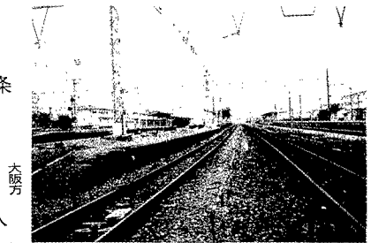
写真-1 改良前の尼崎駅構内
