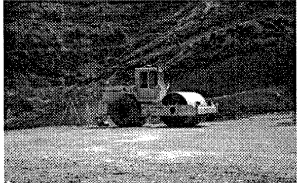
写真1 盛土の締固め管理状況
