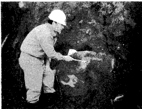
写真-3 露頭した転石の探査
