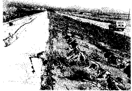
図-1 八郎潟堤防の破壊
