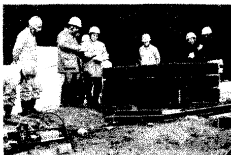
写真-1 現場大型簡易一面せん断試験
