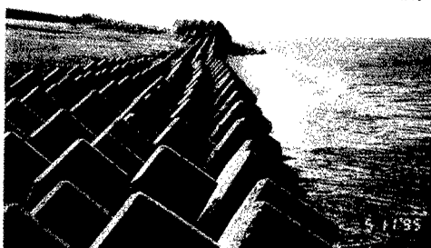
写真-2 1995.5.11 写真1の一段低いところの横断。ブロックは散乱せず、ほぼ当初の形状のままで、陸側には砂が溜っている。写真1のように頭が埋る程、海側にも砂がつくことがある。
