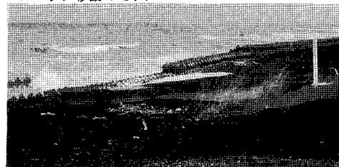
写真-1 砂地盤に格子網上の消波工は3年後約2.2m沈下。砂がつき頭も殆ど見えないが、シケでも侵食されない。少し高いのは着上げ。一段と高いのは捨石基礎をしたか所。
