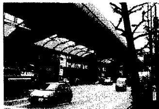
写真7 (高架橋A) 橋軸方向視点
