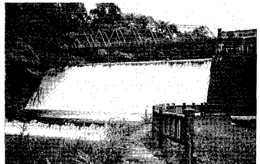
写真-2 藤倉水源の堰堤
