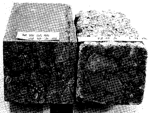
写真-1 下水処理場暴露試験結果 （左：水中養生、 右：一年間下水暴露）
