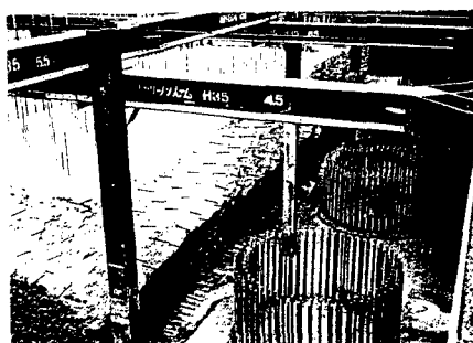
写真－2 既設フーチングはつり完了状況
