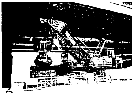
写真-1 桁下制約下での杭施工状況
