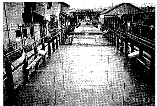
写真4 気泡モルタル盛土
