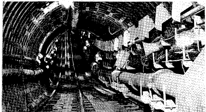
写真-1 急勾配部施工状況
