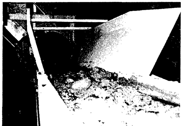
写真-1 排土状況
