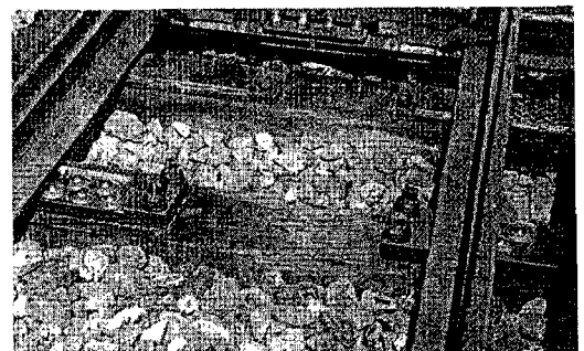
図3 ボールベアリング床板
