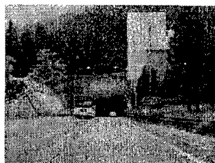
図-1 実走実験対象トンネルの1例 （敦賀TN：上り）
