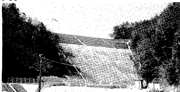
図-1 超高盛土法面( H=89.6\text{m} )
