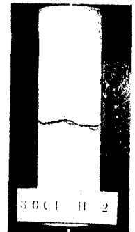
写真-1 輪切り状ひび割れ
