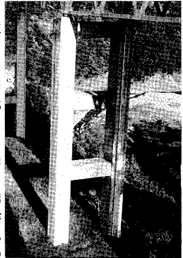
写真-1 多層RCラーメン橋脚
