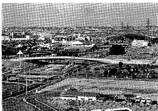
写真－1 稲城中央公園連絡橋
