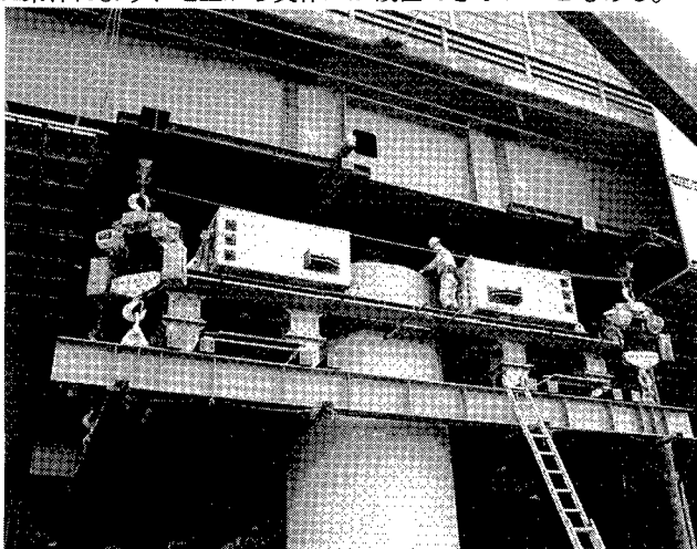
写真－1 プレキャストコンクリート架台の現場施工状況
