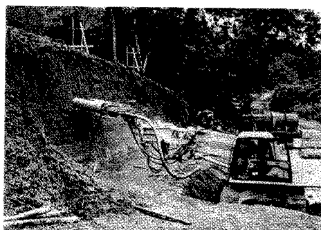
写真-1 施工状況
