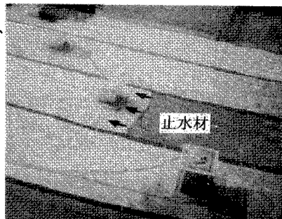
写真－1 止水材の注入状況
