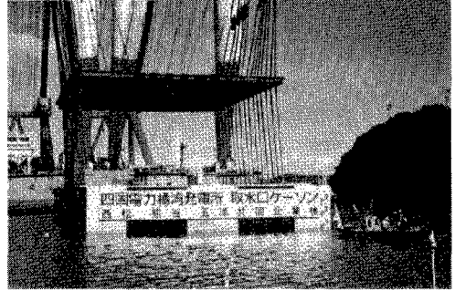
写真-1 取水口ケーソン据付状況
