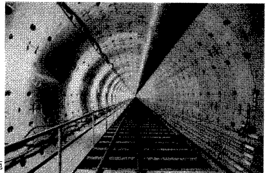
写真－1 トンネル施工状況
