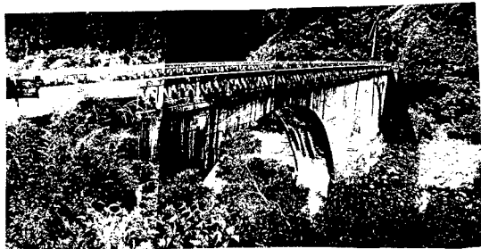
写真1 二股橋の現況
