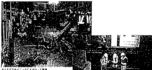
由于ロッドの推進により、フローケーターによる先端位置検知
