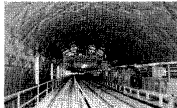
写真-4 防水シートが取付けられた坑内
