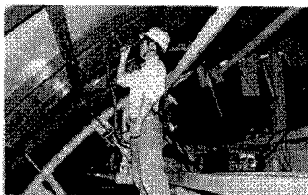
写真-3 防水シート溶着
