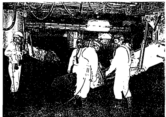
写真-1 ヘリウム混合ガス・メンテナンス状況
