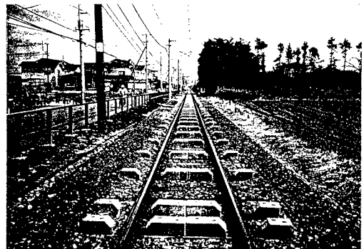
写真－1 木マクラギのみのロングレール
