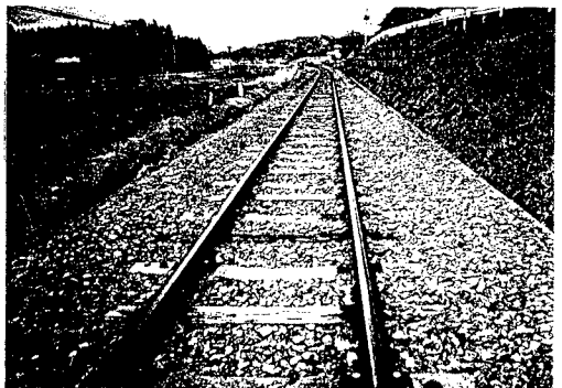
写真－2 木・PCマクラギ混合のロングレール
