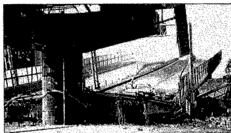
写真1 S3桁およびS4桁の落橋
