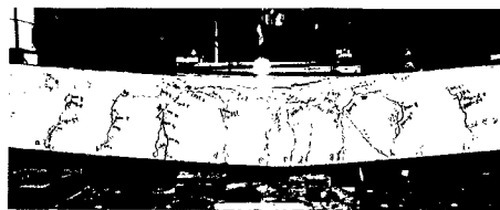
写真-1 破壊状況
