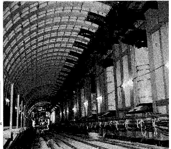
写真-1 完成した一次覆工構造
